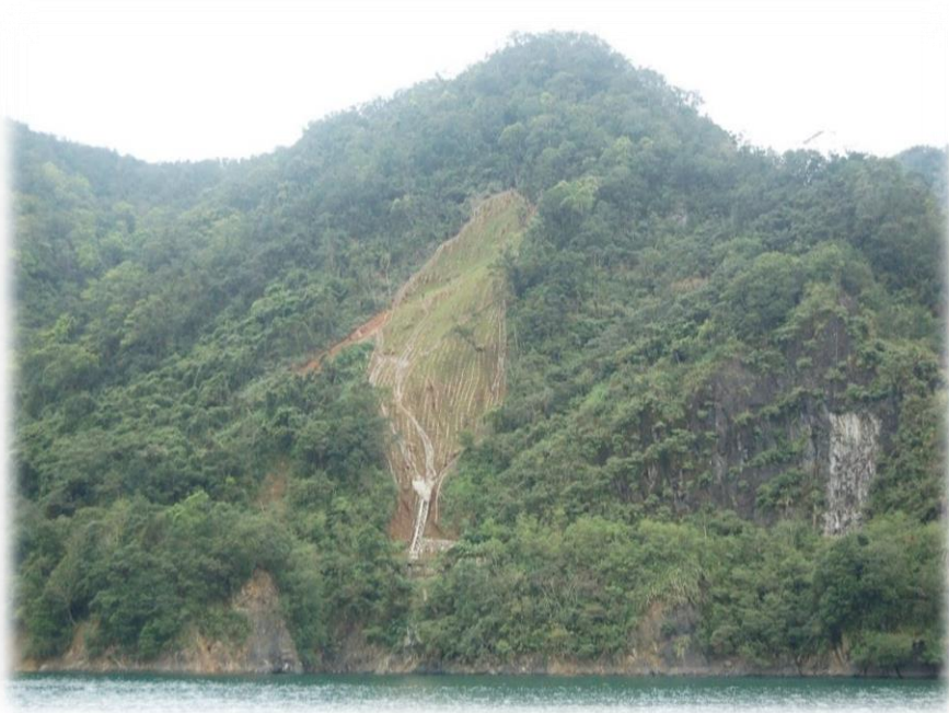
104年蘇迪勒風災-R11崩塌地整治
